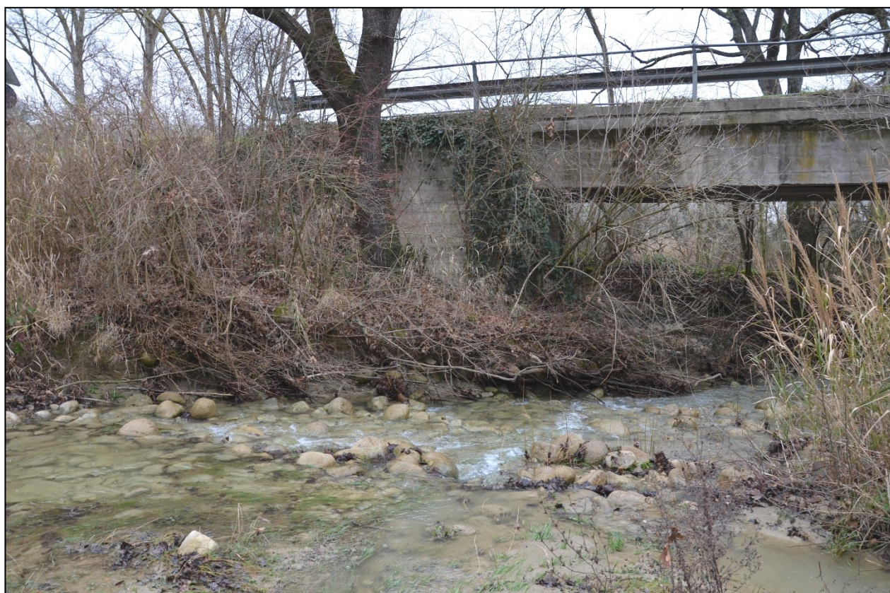
Foto 8 – Ponte di Via delle Cannelle. Intervento di pulizia del corso d'acqua e risagomatura dell'alveo.
