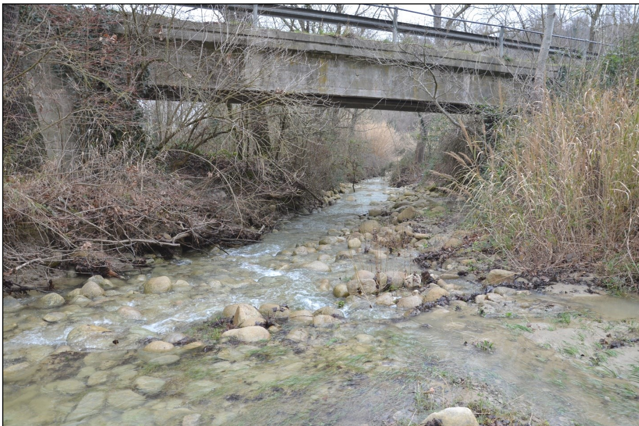
Foto 7 – Ponte di Via delle Cannelle. Intervento di difesa delle pile dall'erosione e scalzamento del basamento.
