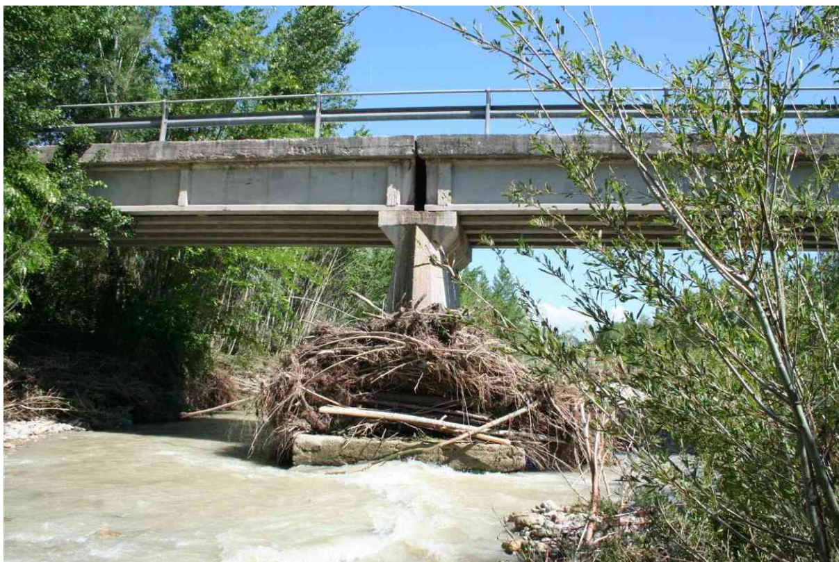
Foto n. 13 - Ponte sulla Strada Comunale dei Gessi. Vista da monte della pila da proteggere con accumulo di materiale legnoso.
