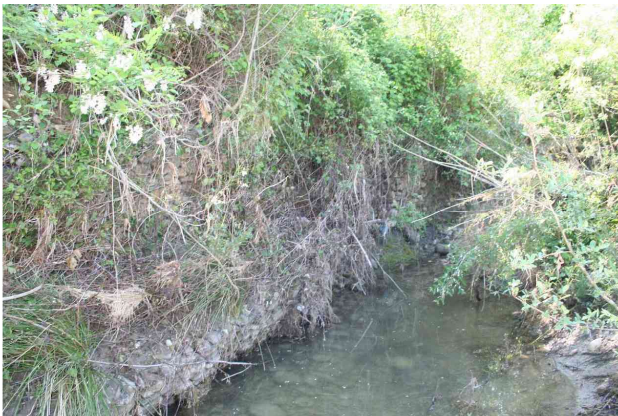
Foto n. 12 - Gabbionata in via di progressivo ribaltamento per scalzamento al piede.
