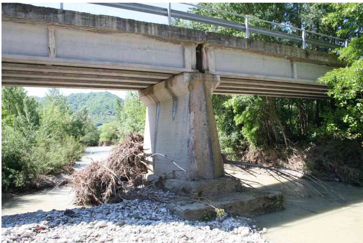
Foto n. 14 - Ponte sulla Strada Comunale dei Gessi. Vista da valle della pila da proteggere.
