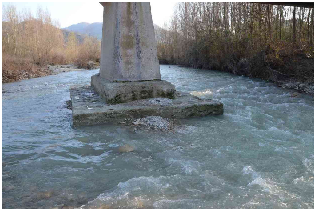
Foto n. 15 - Azione della corrente sulla fondazione in parte scoperta.
