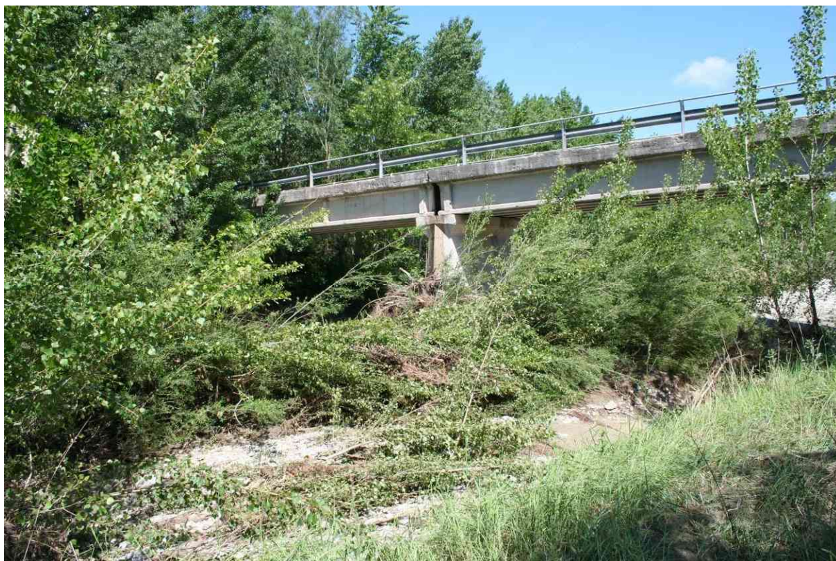
Foto n. 16 - Vista del ponte da monte. E' evidente la necessità di ripulire la parte di alveo sottostante la campata destra per distribuire meglio il deflusso.
