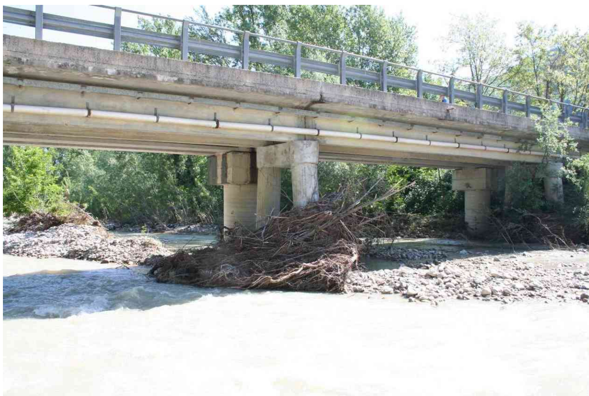
Foto n. 18 - Ponte sulla strada Comunale di Camino (vista da monte) con accumulo di materiale legnoso.
