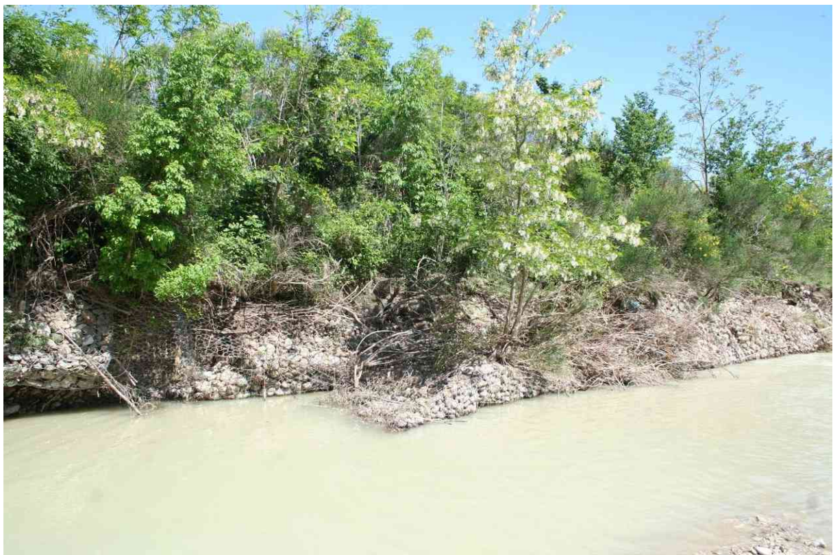
Foto n. 8 - Dettaglio della preesistente gabbionata in gran parte collassata.
