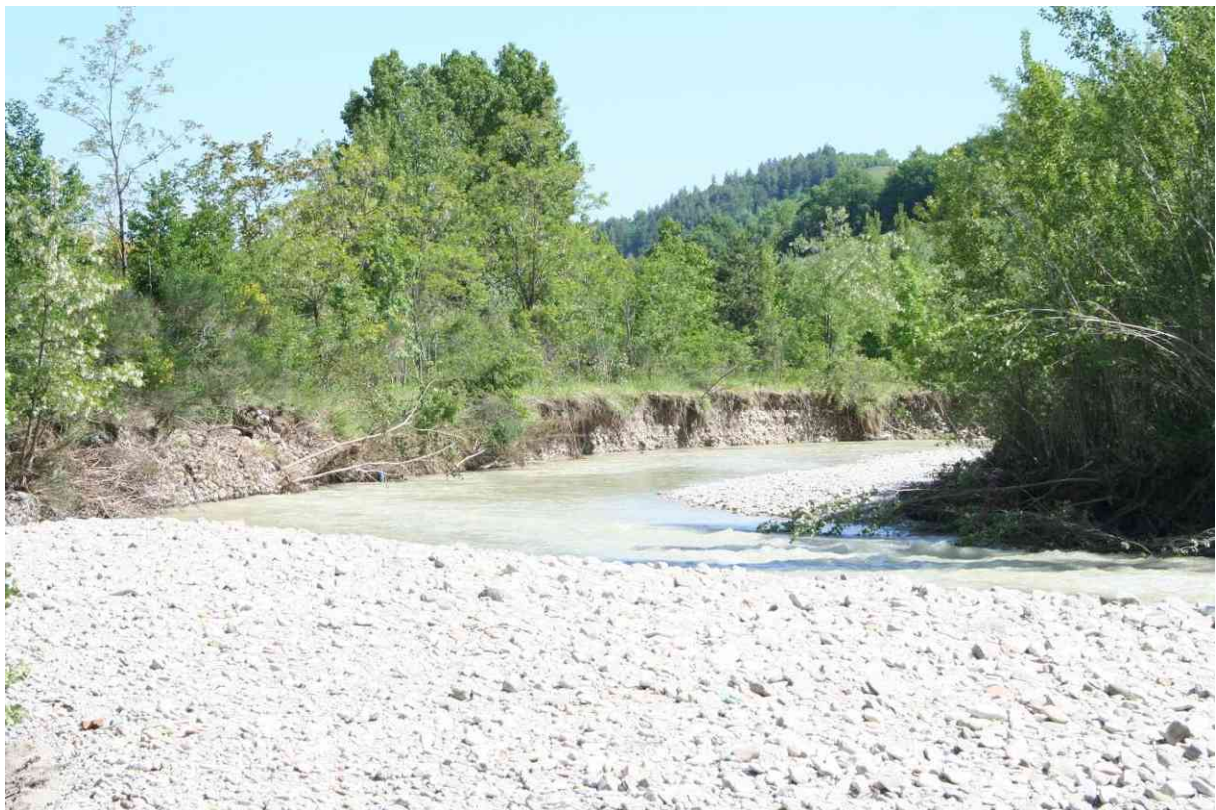
Foto n. 6 - Sponda sinistra soggetta ad erosione fluviale (scogliera DS2).
